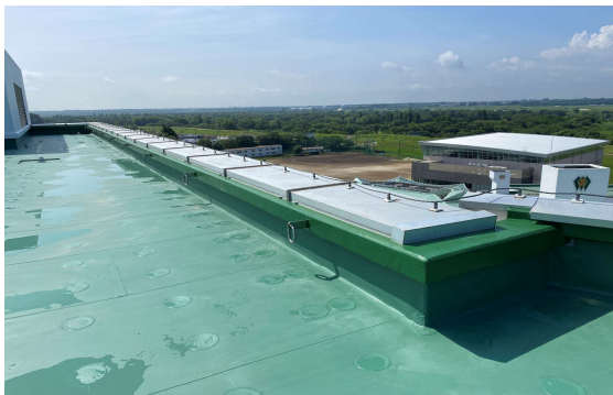
<屋上防水改修>
