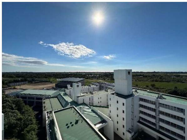
＜屋上防水改修＞
