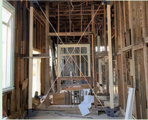
↑施工前のエントランス
