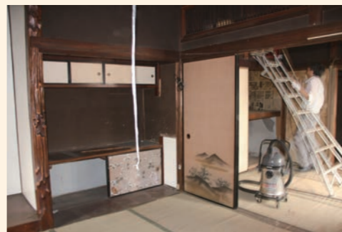
改装中の様子。
