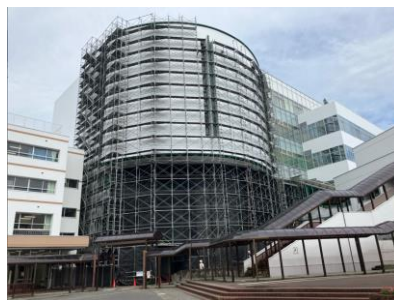
(改修工事の様子)
