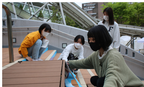
隙間のないように貼っていく
