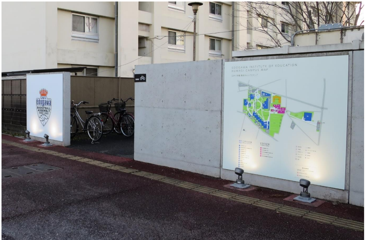
第二体育館入口の外構看板の貼換工事
