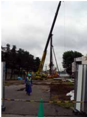
工事着工の様子
