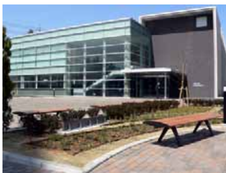
入試広報センター棟外観
