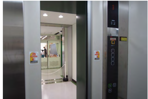
エレベーター
