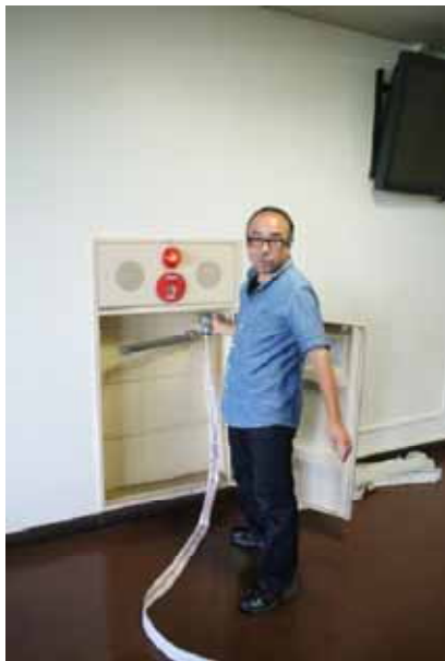
7 屋内消火栓訓練バルブを開ける
